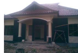
Kantor BPBD Cilacap sedang dibangun
